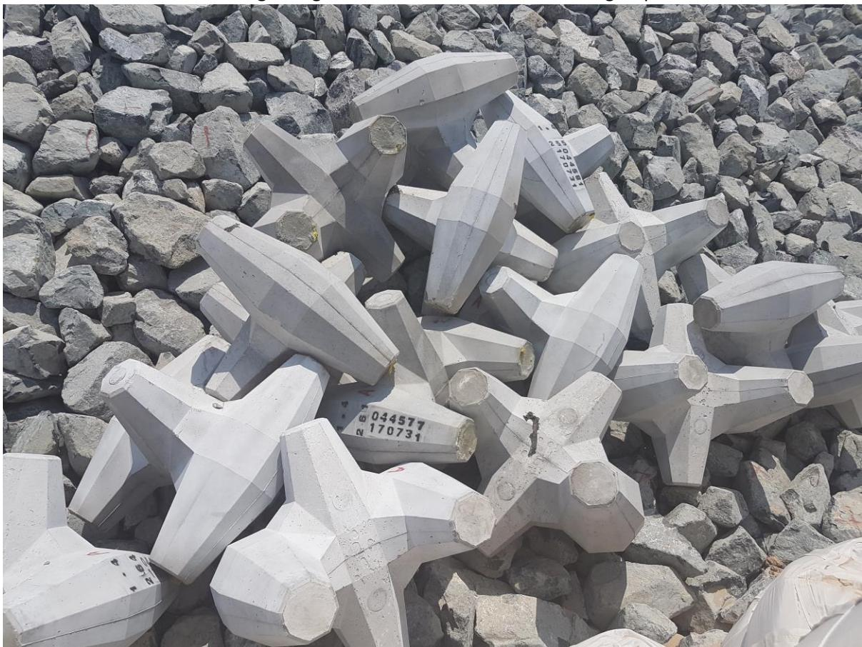
Dans la littérature technique l'imbrication correcte est acquise quand il est impossible de sortir un bloc sans déplacer auparavant ceux qui sont posés sur lui.
