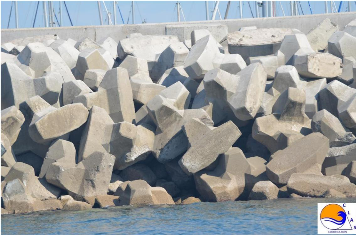
Como parte de un procedimiento de inspección más completo, CLASE B se puede extender a toda la construcción del rompeolas. Se puede construir un caparazón de CLASE A en un rompeolas de CLASE B. El cliente es informado de los motivos de esta clasificación de la estructura, a pesar de la buena ejecución del trabajo de construcción de la capa de armadura.
