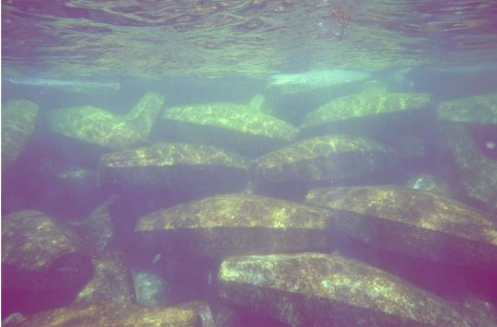
Bloque roto debido a un movimiento debido a una falla de contacto
