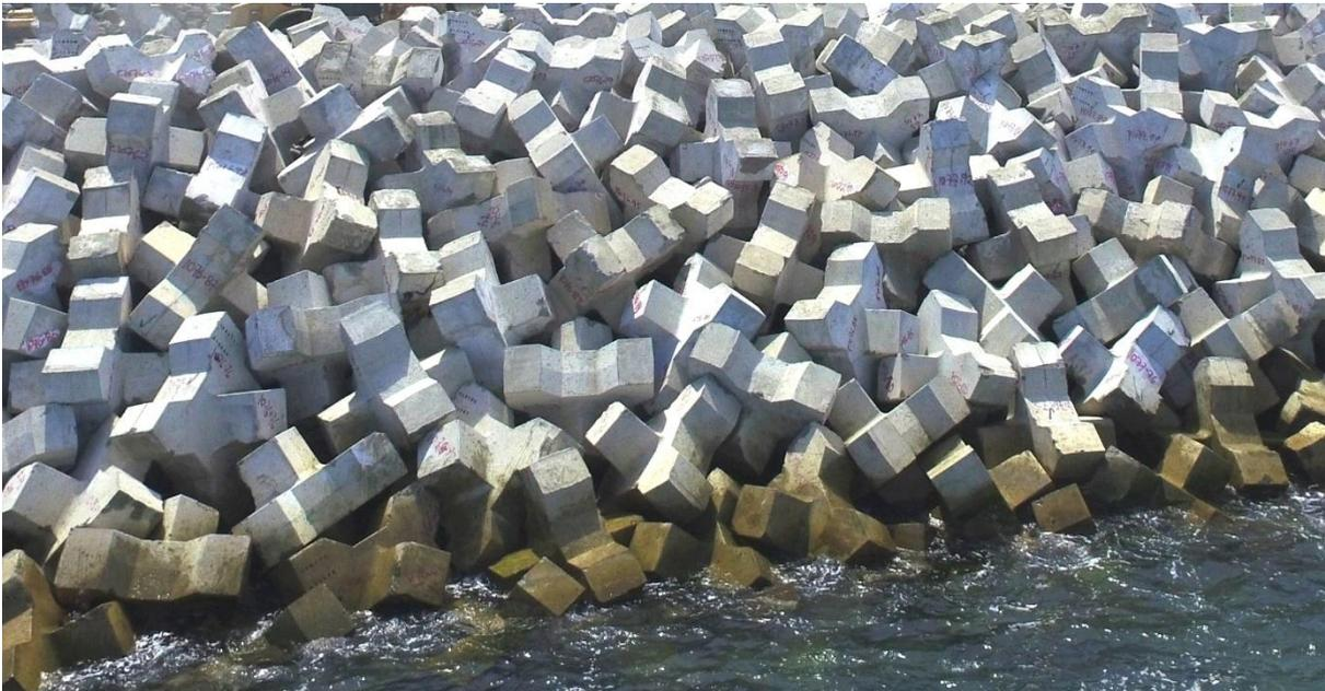
Por experiencia y después de evaluar, colocar, reparar más de un millón de bloques ACCROPODE™, ACCROPODE™ II, CORELOC™, ECOPODE™ y X-bloc®, sabemos y enseñamos que la densidad de construcción siempre es buena o demasiado alta cuando la imbricación esta buena.
