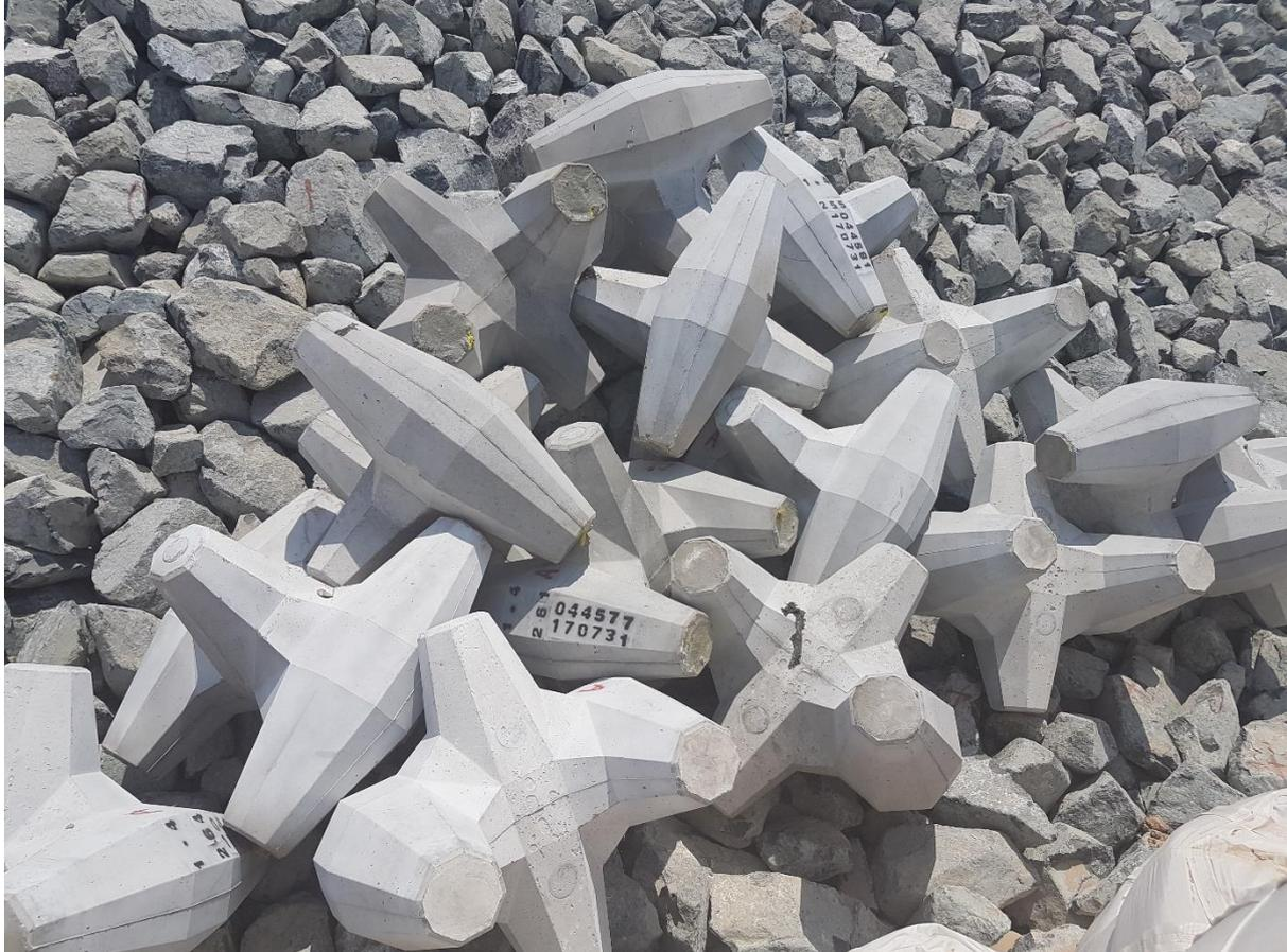
En la literatura técnica, la imbricación correcta se adquiere cuando es imposible sacar un bloque sin mover previamente los colocados sobre él.
