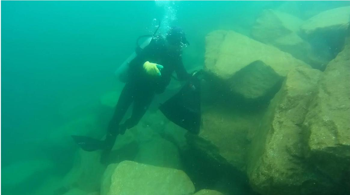
Este no es un caso extremo y no es raro. La capa inferior no se ajusta al diseño o la tecnología. La instalación de los bloques ACCROPODE™, ACCROPODE™II, ECOPODE™, CORELOC™ o X-bloc®, que deben cumplir con las reglas de tolerancia de las subcapas como se define en sus TID respectivos, no es posible. Esto marca un punto de parada. Los inspectores de CLAS producen un video con medidas para justificar sus decisiones.
