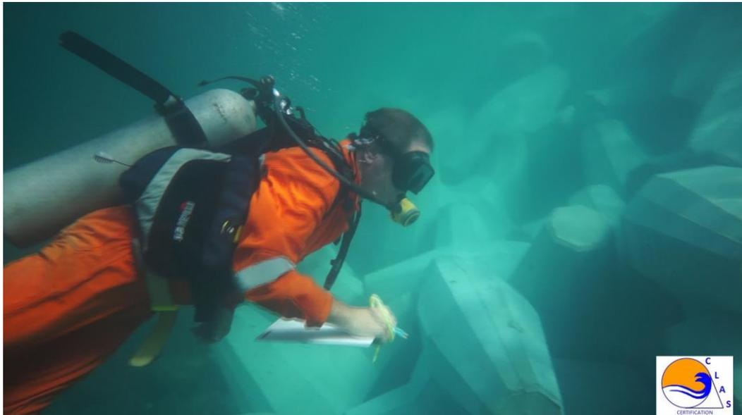
Supervisión de la construcción de la carcasa XBLOC® que protege las instalaciones petroleras de ZAKUM ISLAND en ABU DHABI
